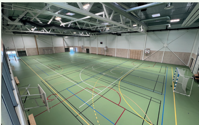
Flerbrukshallen har en størrelse med en håndballbane. Her er det også tribuneanlegg og andre fasiliteter som hører naturlig til et slik anlegg.
